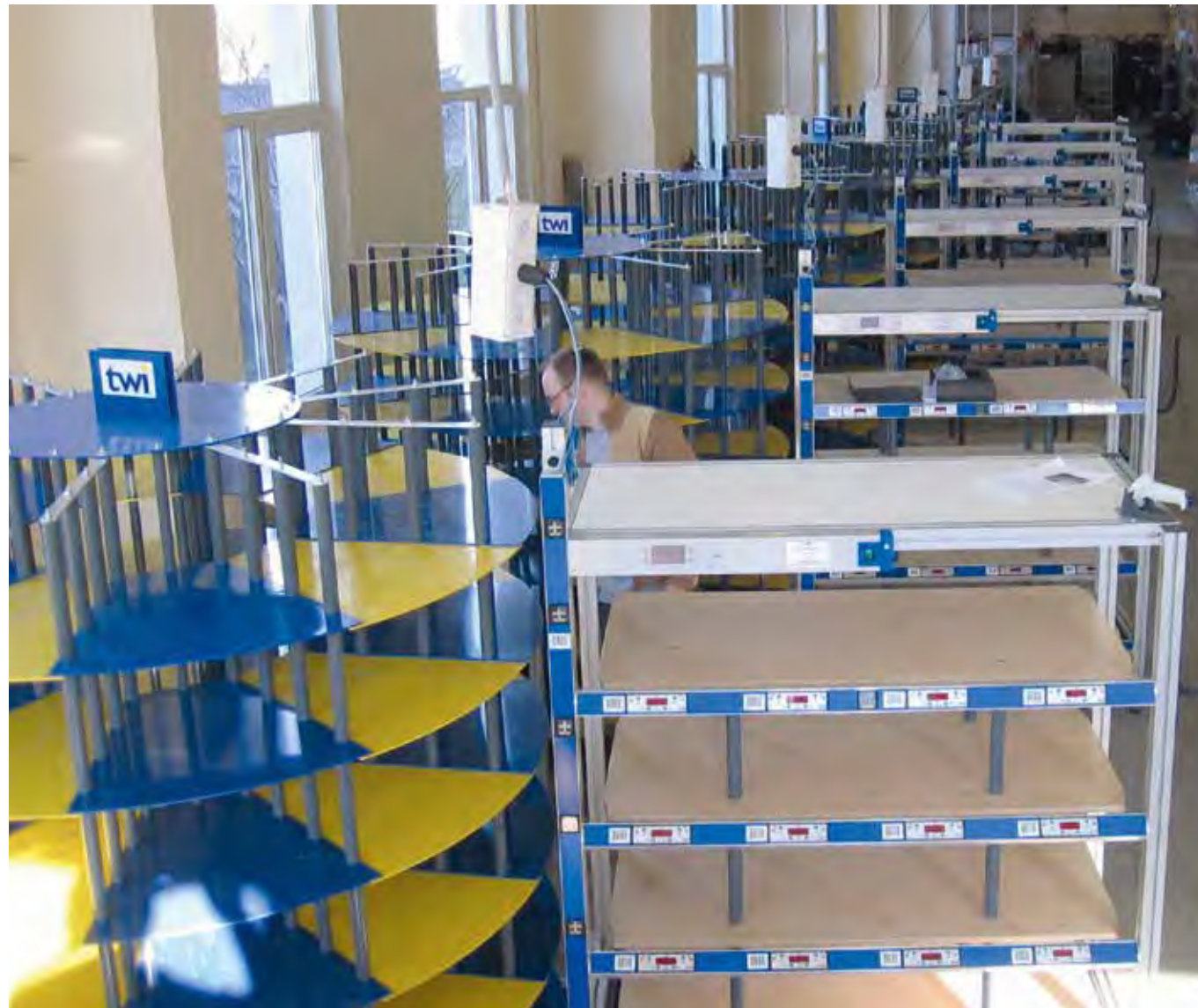
Installation von 9 AERO in St. Petersburg, Russland
